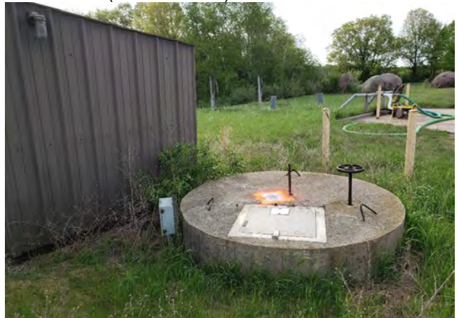
BM Manhole (Concrete Mark)
