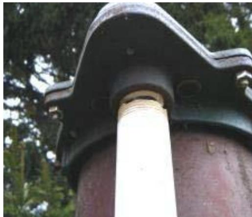
Broken PVC electrical conduit
