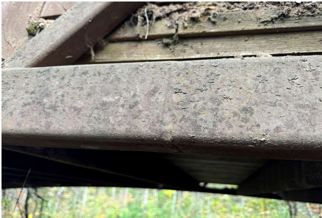
Bot chord butt weld
