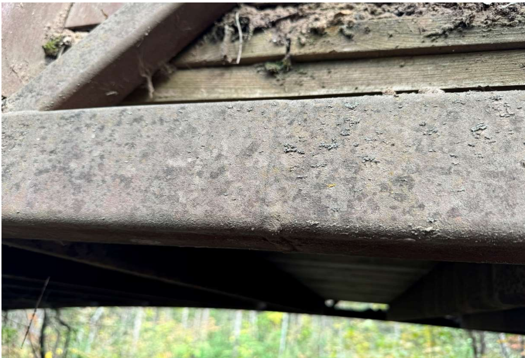
Bot chord butt weld
